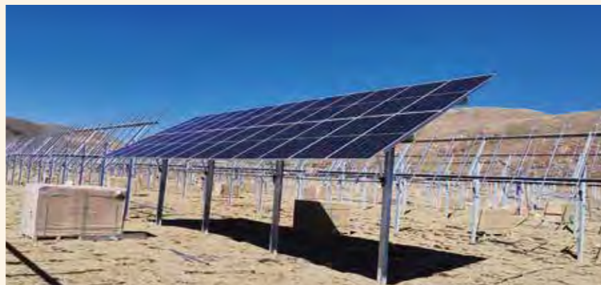
●国电投甘孜州正斗实验实证光伏基地项目：固定可调支架
