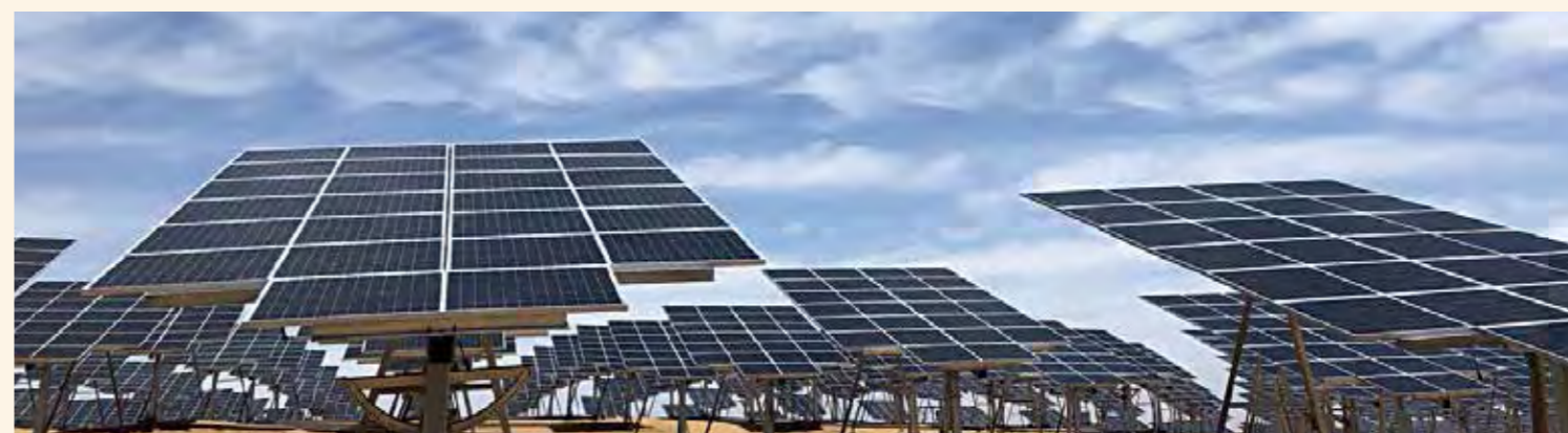
●国电投甘孜州正斗实验实证光伏基地项目：固定可调支架
