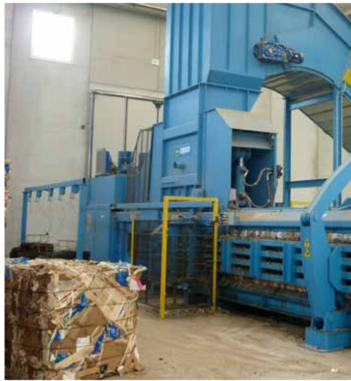
Imballaggio rifiuti - Waste packaging
