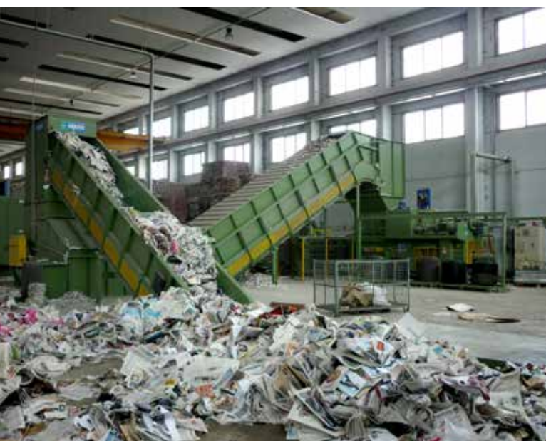
Impianto di triturazione e imballaggio - Shredding and baling plant
