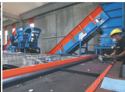
Ligne de recyclage de DEEE
